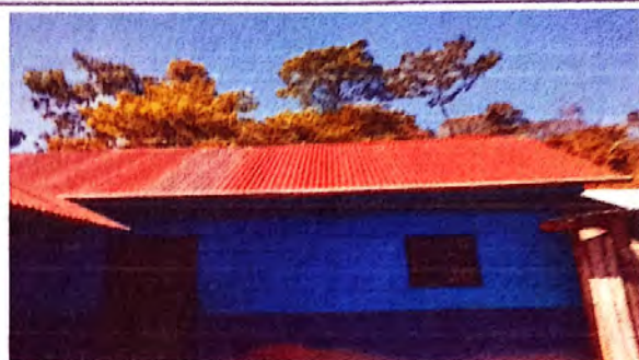
Foto 2: Sustitución de laminas sobre el aula de cuarto, quinto y sexto primaria.
