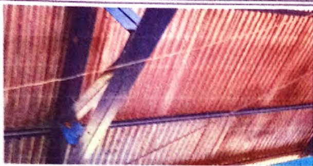
Foto 1: Reparación de cubierta de lamina a troqueladas
