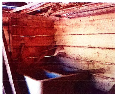
Foto 12 : Reaparacion de red de agua entuvada
