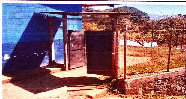
Foto 9: Reparacion de portones
