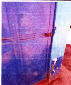
Foto 3: Reparación de puertas de baños
