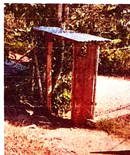
Foto 10: Reparacion de portones
