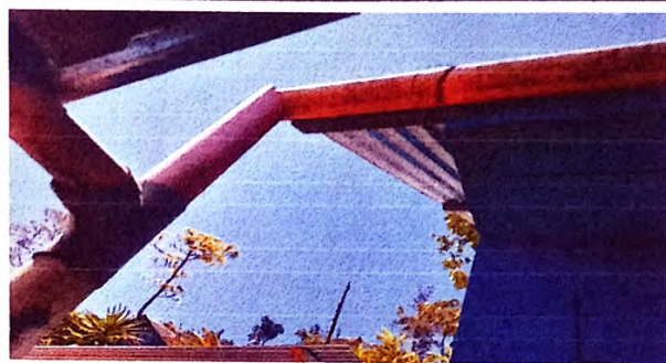
Foto 8: Susutitucion de canales pluviales
