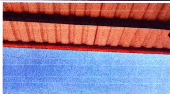
Foto 6: Sustitución de canales pluviales
