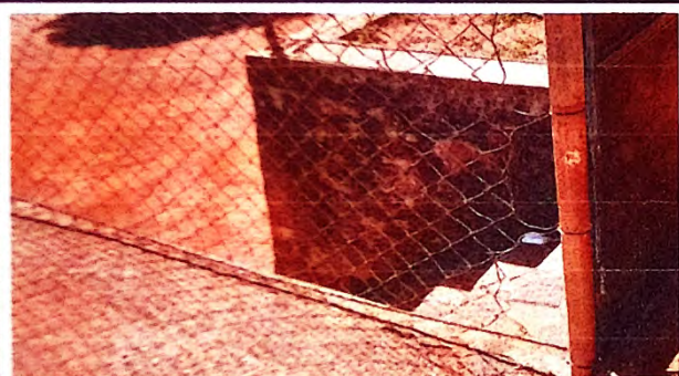
Foto 15 reparacion de muro de contencion
