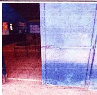
Foto 4: Sustitución de puerta principal del aula de primero, segundo y tercero primaria
